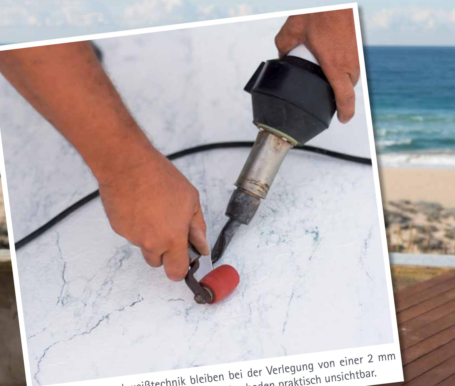
Dank der Stumpfschweißtechnik bleiben bei der Verlegung von einer 2 mm Abdichtungsbahn die Fugen auf dem Beckenboden praktisch unsichtbar.
